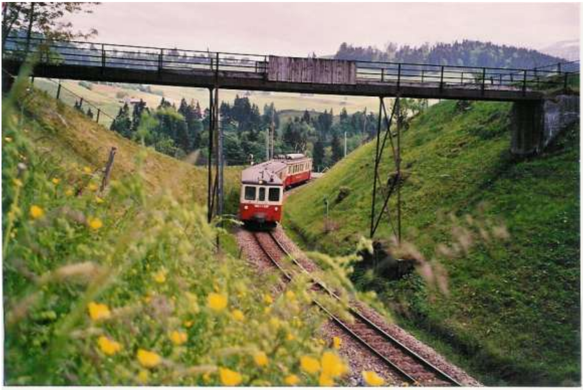
Zwischen der Kreuzungsstelle Sulzbrunn und Waldstatt wird der Zug gleich den Murbachrank erreichen.
